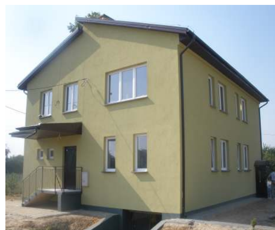
WOZ Radawczyk w trakcie remontu
